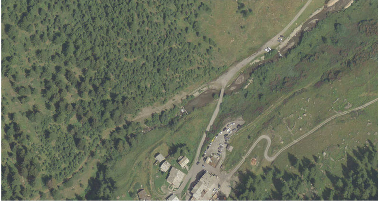
Vista aerea di dettaglio della zona dell'opera di presa, posta proprio al centro della foto In basso i fabbricati di Planaval
